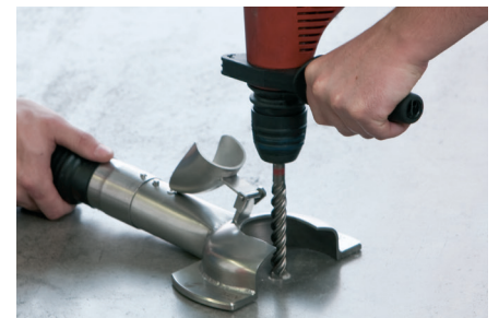
Bohren mit handelsüblichem Bohrhämmer
