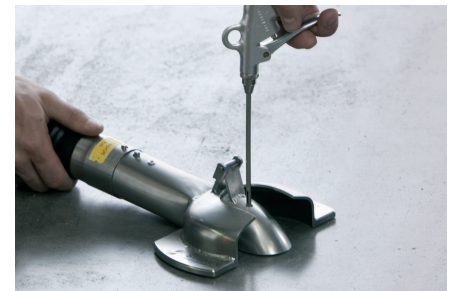
Ausblasen des Bohrlochs mittels Luftpistole mit Rohrverlängerung
